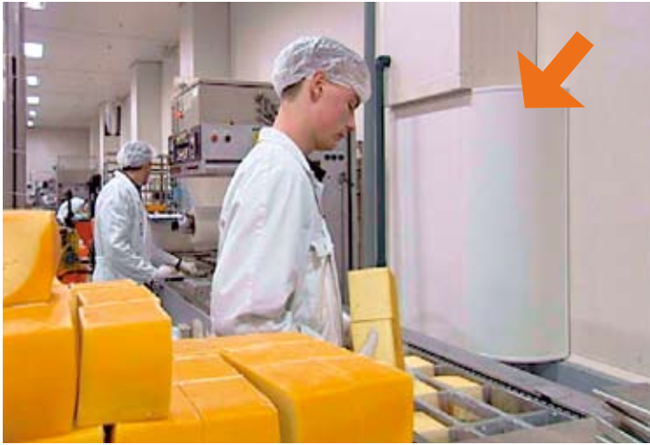
In sommige ruimten koelen we enkel de onderste luchtlagen door via roosters onder aan de wand koude lucht in de ruimte te blazen.
