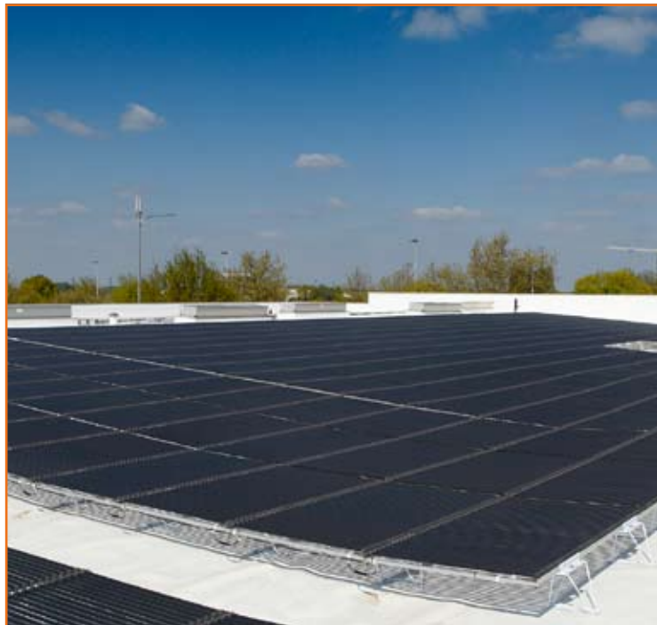
Zonnepanelen van de derde generatie, zoals hier op het dak van Colruyt Hasselt, zetten zowel direct als indirect invallend licht om in stroom.
