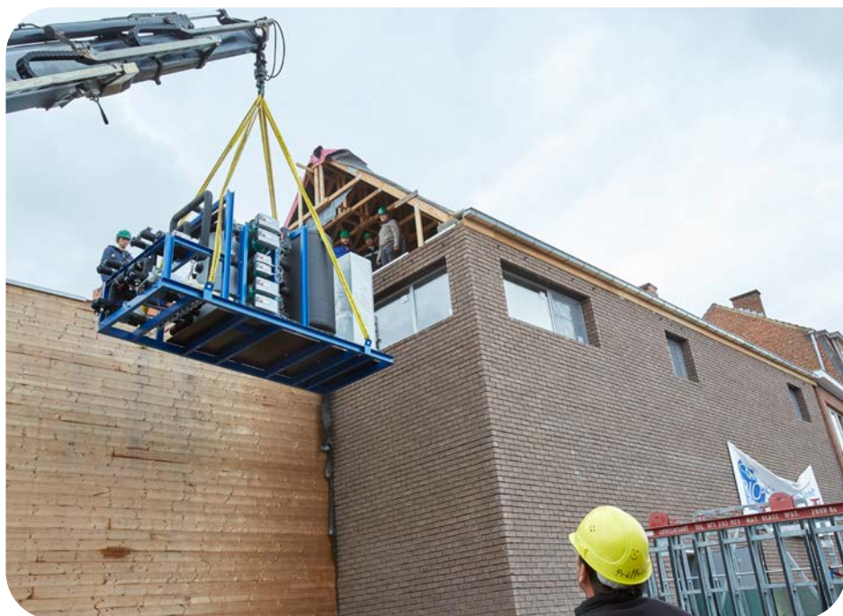
Propanainstallatie bij Bio-Planet in Bergen
