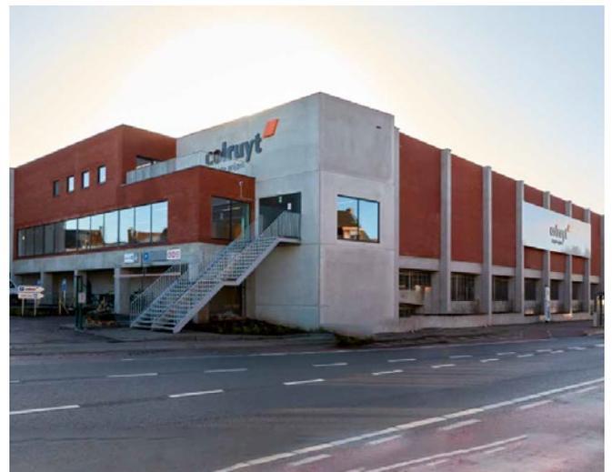
Le magasin Colruyt de Temse nous fournit un bel exemple de construction circulaire grâce à ses **pierres de façade à CO<sub>2</sub> négatif**, constituées à 80% de matières premières recyclées.
