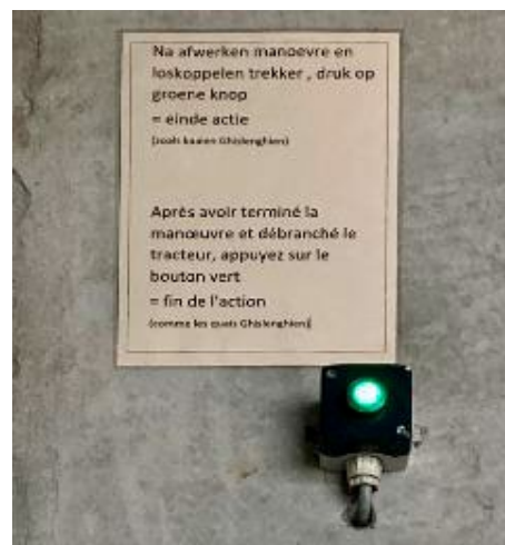
Figure 4 – Le bouton vert à gauche de la porte du quai. Le chauffeur l'appuie après être arrivé au quai.
