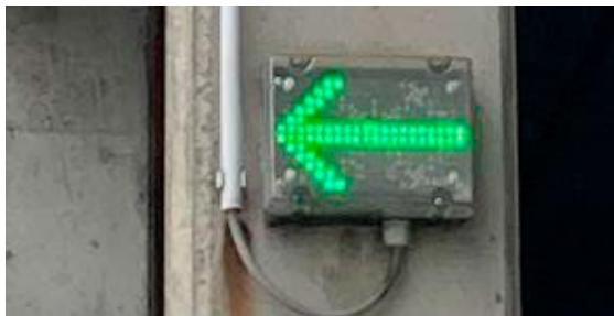
Figure 1 - La flèche verte est allumée. Le véhicule peut être mise à quai ou déplacé.
