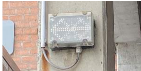
Figure 2 - La flèche verte est éteinte. Le véhicule ne peut pas être mise à quai ni déplacé.
