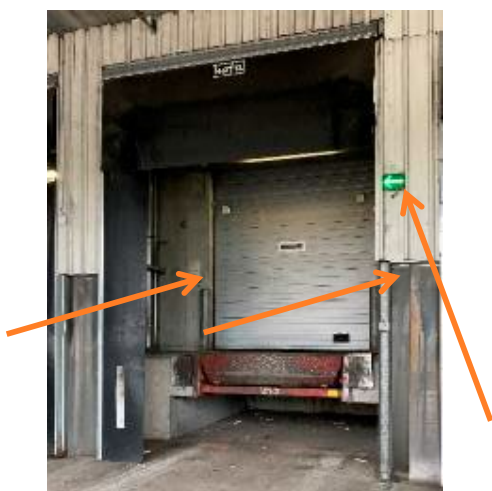
Figure 3 - Quai avec la flèche verte allumée. Le bouton vert se trouve à l'un des deux côtés de la porte.
